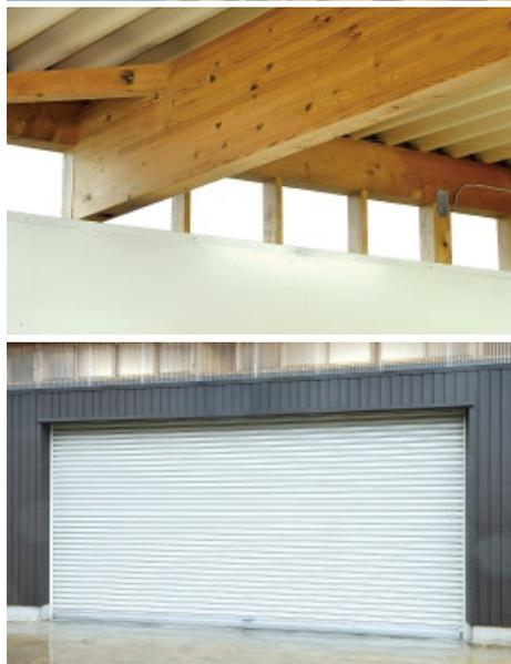
上ノ Garage は安全を考慮して、あまり大きな窓を設置したくないところ。そこでTさんの発案によりポリカーボネートの透明な波板を用いて明かりが入るように設計。下ノ Garage シャッターは『文化シャッター』製軽量シャッター・モードWを採用。シャッターのサイズに合わせて間口を設計しているのでサイズはぴったり。
